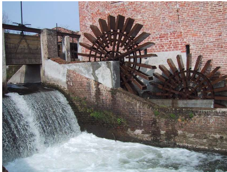
Mulino di Mora Bassa (Vigevano), particolare.
